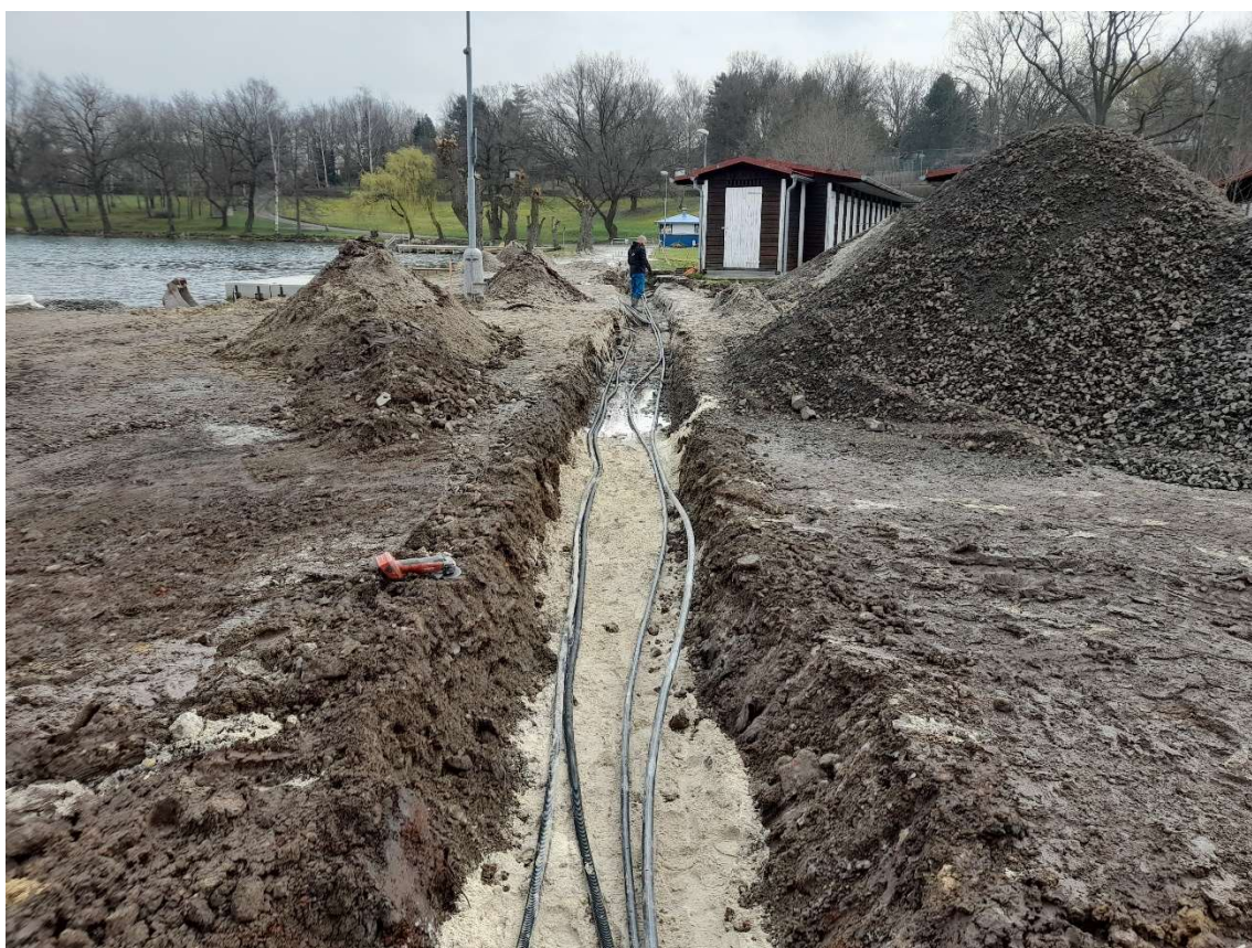
Zemní práce pro splaškovou kanalizaci a vodovod v prostoru u nového stožáru
