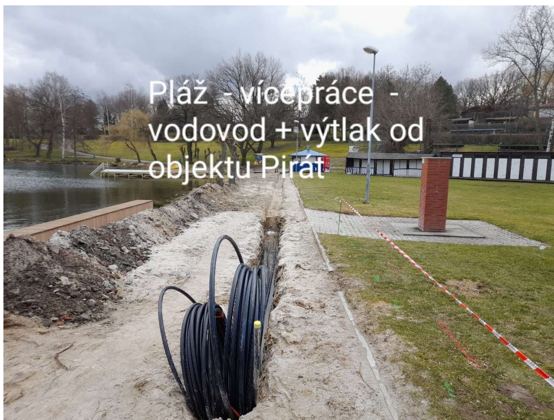
Zemní práce pro splaškovou kanalizaci a vodovod v prostoru u nového stožáru
